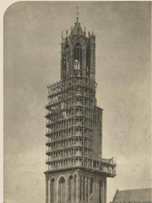
In 1912 stond de gehele westkant van het tweede vierkant in de steigers. Onderaan werd een nieuwe hijsbrug gebouwd, die werd uitgerust met een elektrische lier. (Het Utrechts Archief)
